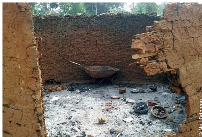
Une maison détruite – la plupart étaient construites en terre crue ou en torchis.
